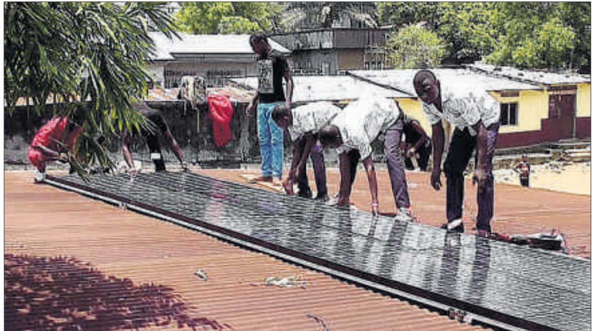
«Photovoltaik» ist ein neuer Ausbildungszyklus für die Elektriker.
