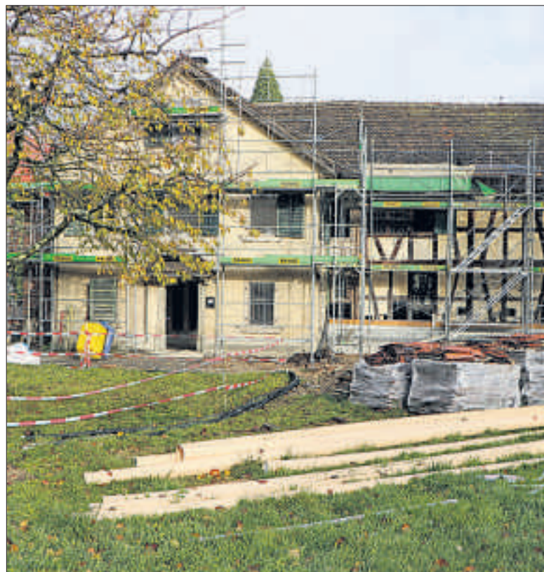
Die Bauarbeiten sollen Ende Juni 2018 fertig sein.
