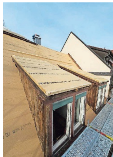
Einbau der Dämmung.
