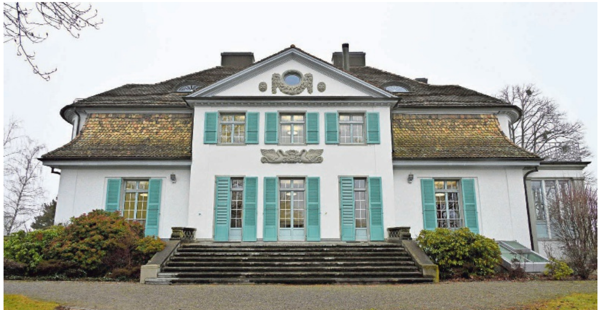
Die Villa Spinnergut, umgeben von Park und Feldwegen, ermöglicht einen sicheren Schulweg.
