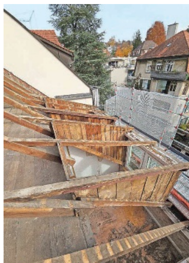
Rückbau der alten Eindeckung.
