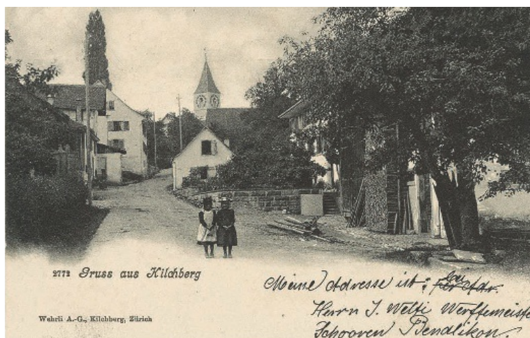
Dorfstrasse mit Blick zur Kirche.
