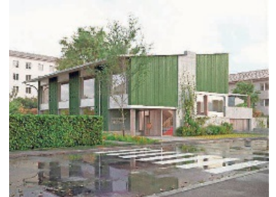
Wenn der Souverän im September Ja sagt zum Doppelkindergarten Bächler, ist der Baustart im Sommer 2027 geplant. BILD ZVG
