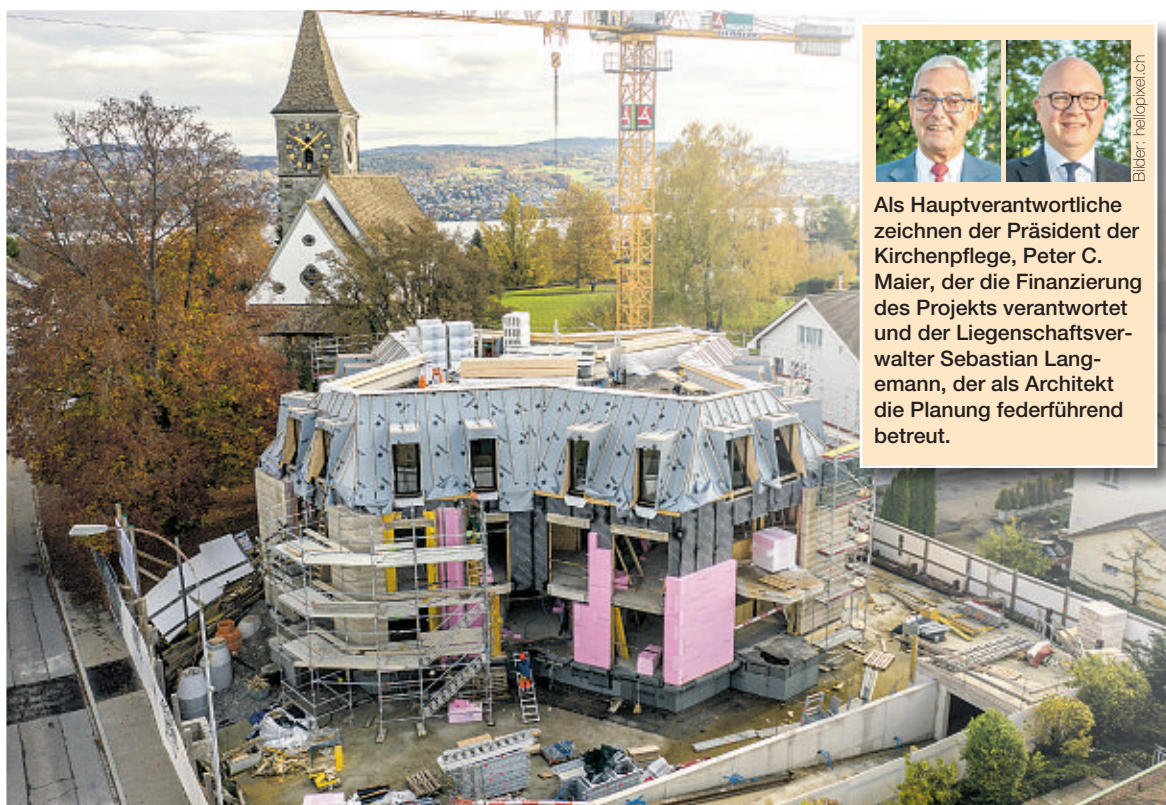
Schon ein dreiviertel Jahr später war der Rohbau fertig. In dieser Bauetappe wurde sichtbar, dass sich das Mehrfamilienhaus gut in die Kernzone integriert.
