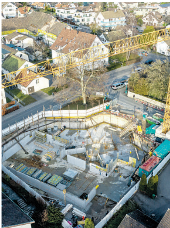
Im darauffolgenden Winter wurde das Tiefgaragenfundament ausgegossen. Zu jeder Wohneinheit gehören je zwei Tiefgaragenparkplätze.
