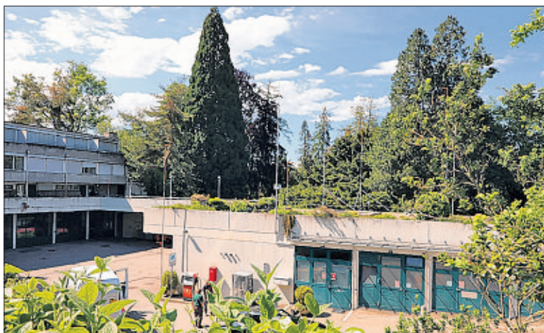
Augenschein vor Ort: die Bauarbeiten des neuen Werkhofs und Feuerwehrdepots sind erstmals auf Eis gelegt.
