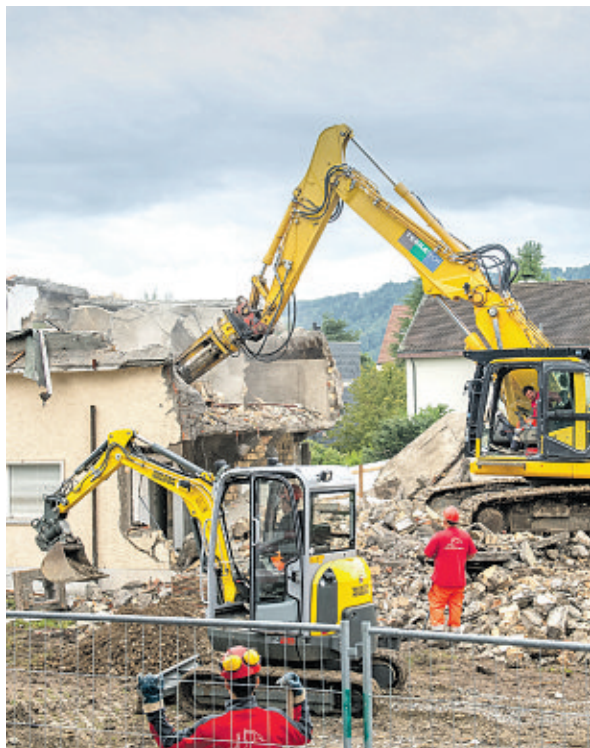
Zunächst wurde das alte Pfarrhaus, das nicht unter Denkmalschutz stand, abgerissen. Die weiträumigen Ausmasse des Grundstücks wurden nun sichtbar.
